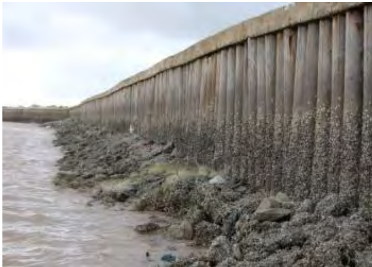
Hình 24. Tường biển bằng cột bê tông Nguồn: Holger Schuettrumpf & Peter Froehle
