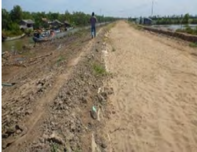
Hình 32. Nâng cấp đê đất. Nguồn: Stefan Groenewold
