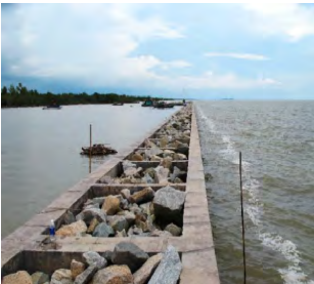
Hình 11. Công trình phá sóng tách rời dọc bờ biển Tây tỉnh Cà Mau. Phía dưới bên phải là dạng mới cải tiến, kết cấu trụ bê tông lấp đầy đá và có những bộ phận có thể được thu hồi.
