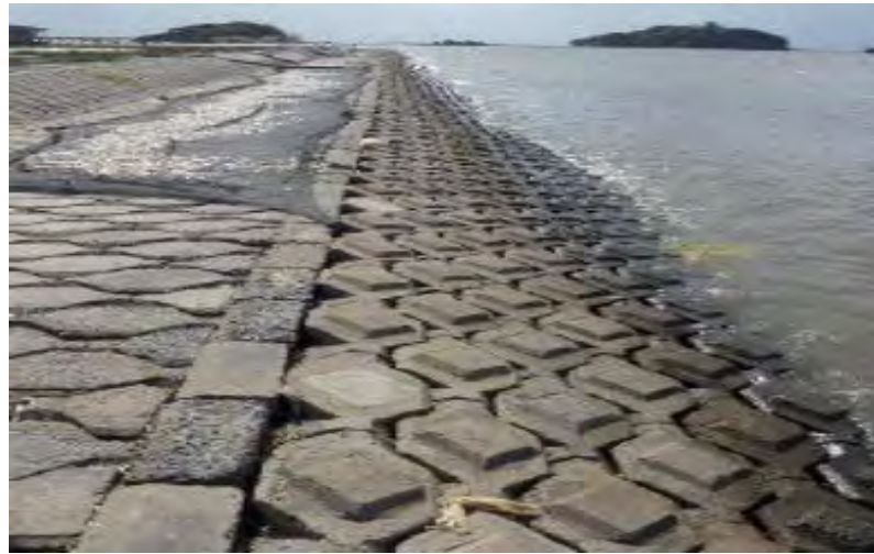
Hình 29. Kè lát mái cấu kiện bê tông đúc sẵn
