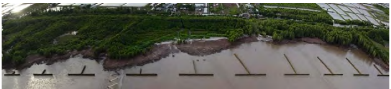
Hình 47. Khôi phục các bãi bồi bị xói lở bằng hàng rào chữ T ở tỉnh Bạc Liêu (ĐBSCL, Việt Nam). Các cấu trúc dọc bờ khép kín các khoảng trống bị xói lở trong rừng ngập mặn bằng cách kết nối các mũi đất còn sót lại. Nguồn: Công Lý và G.E. Wind 2013
