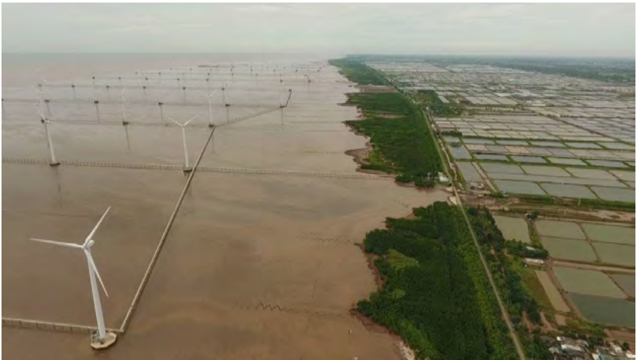
Hình 67. Công trình điện gió gần bờ ở bờ Biển Đông, tỉnh Bạc Liêu. Phương pháp quy hoạch không gian vùng bờ (CSP) cố gắng lập bản đồ các rủi ro tiềm ẩn và cơ hội sử dụng bất kì khu vực ven biển nào. Một quy hoạch chung cho các công trình điện gió gần bờ gắn với bảo vệ vùng ven biển có thể mang lại nhiều lợi ích cho cả hai bên liên quan và không nên xem là một mối bất lợi. Nguồn: Sở NN&PTNT tỉnh Bạc Liêu
