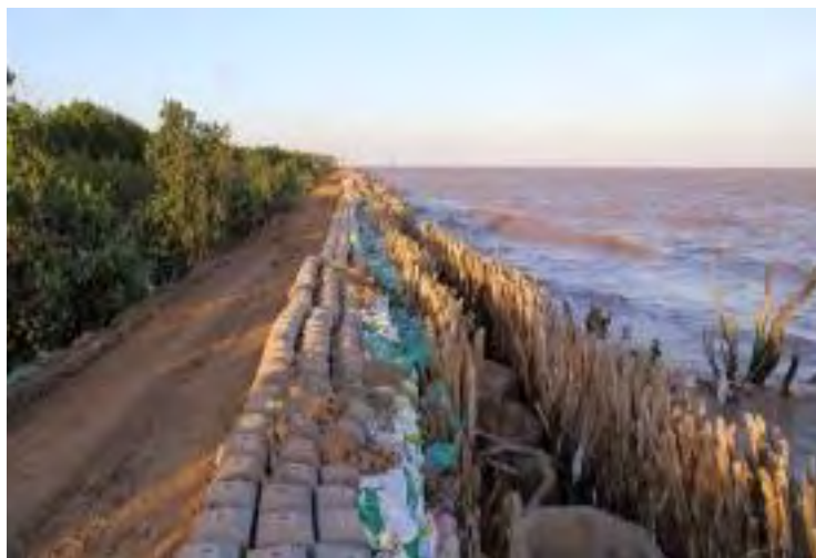
Hình 26. Công trình đê biển kết hợp trong trường hợp khẩn cấp. Nguồn: Holger Schuettrumpf & Peter Froehle
