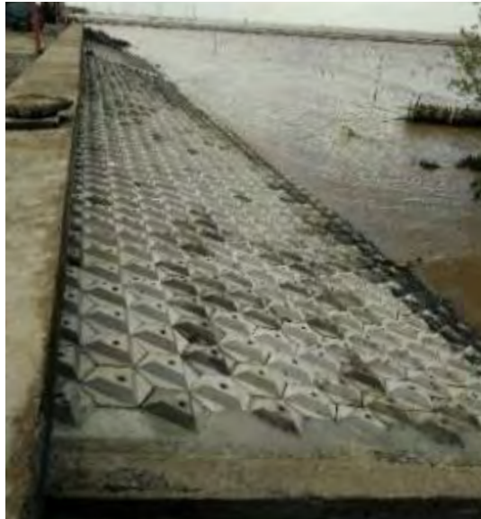
Hình 27. Kè lát mái bằng cấu kiện bê tông cho đê biển.
