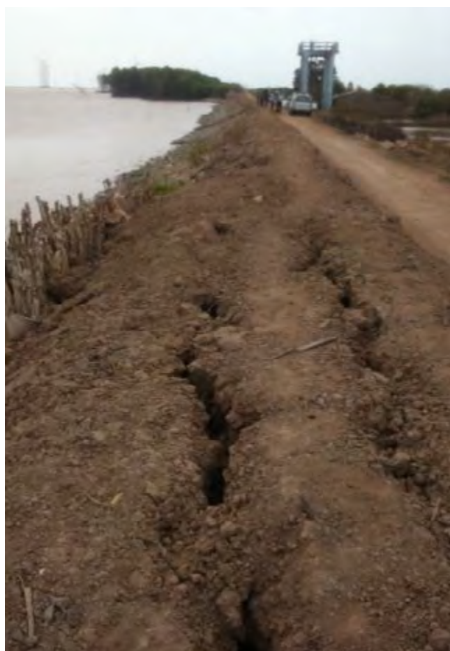
Hình 40. Sự cố đê biển điển hình dọc theo bờ Biển Đông tại ĐBSCL. Khi đê đất có độ dốc lớn và chân đê không được bảo vệ thì cho dù bị sóng đánh ở mức độ vừa phải cũng làm đê bị suy yếu và sụp đổ về phía biển. Khi có những cơn bão trong thời gian dài, mực nước cao và sóng tràn sẽ nhanh chóng phá hủy đê. Nguồn: Frank Thorenz
