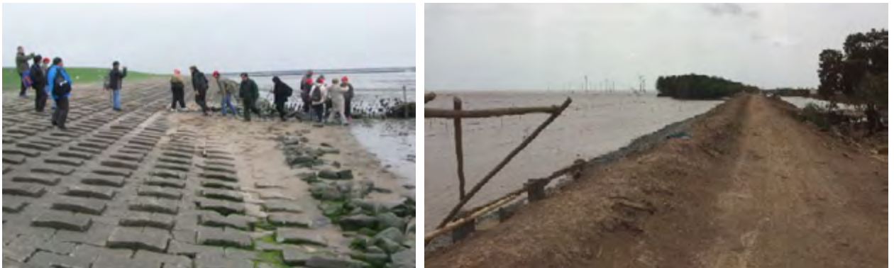
Hình 39. Trái: Tuyến đê biển lộ thiên điển hình tại bờ Biển Bắc ở Đức. Độ dốc của thân đê ở phía biển khá thoải và thậm chí còn thoải hơn ở gần chân đê. Mục đích nhằm giảm hư hại do phản xạ sóng trong thời gian dài. Các tấm bê tông được chèn vào nhau để giảm sóng leo lên mái dốc. Phản xạ sóng sẽ khuấy động môi trường phía trước đê. Các đầm lầy mặn ở phía trước đê là khá điển hình cho các vùng ôn đới trong khi các hệ sinh thái rừng ngập mặn lại phổ biến ở các vùng nhiệt đới và cận nhiệt đới. Hình bên phải: Đê biển tại Biển Tây (Cà Mau) và Biển Đông (Sóc Trăng) với các tuyến đường bảo trì điển hình trên đỉnh đê hoặc trên cơ đê phía đất liền (bên phải). Nguồn: Frank Thorenz
