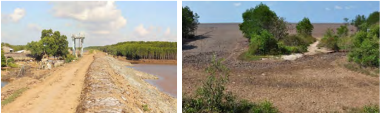
Hình 38. Tuyến đê biển điển hình với lớp kè lát mái đá hộc và vùng bãi triều ở Đồng bằng sông Cửu Long của Việt Nam (phía Biển Đông). Việc bảo tồn phần bãi triều trước đê có tầm quan trọng cao đối với khả năng chống chịu của đê. Nguồn: Frank Thorenz
