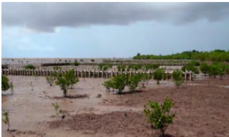
Hình 15. Công trình phá sóng kết hợp và khu vực công trình mỏ hàn.
