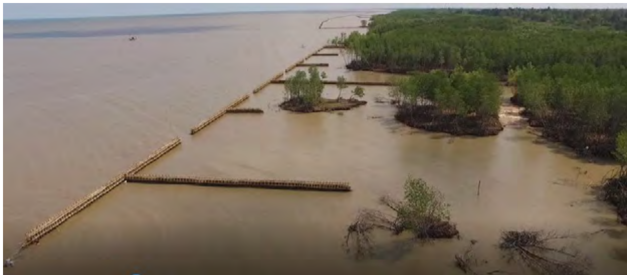
Hình 65. Hàng rào chữ T ở Biển Tây tỉnh Cà Mau. Nguồn: Sở Nông Nghiệp và Phát Triển Nông Thôn tỉnh Cà Mau
