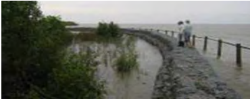
Hình 20. Công trình phá sóng rọ đá. Nguồn: Phan Thanh Tĩnh
