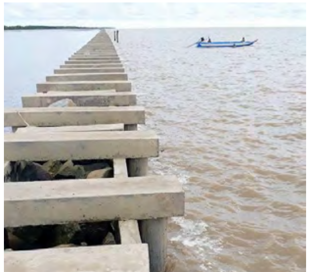
Hình 11. Công trình phá sóng tách rời dọc bờ biển Tây tỉnh Cà Mau. Phía dưới bên phải là dạng mới cải tiến, kết cấu trụ bê tông lấp đầy đá và có những bộ phận có thể được thu hồi.
