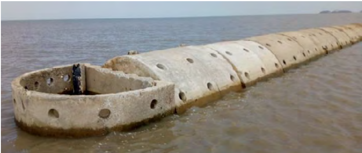
Hình 12. Công trình phá sóng tách rời “Đê trụ rỗng”. Nguồn: Frank Thorenz
