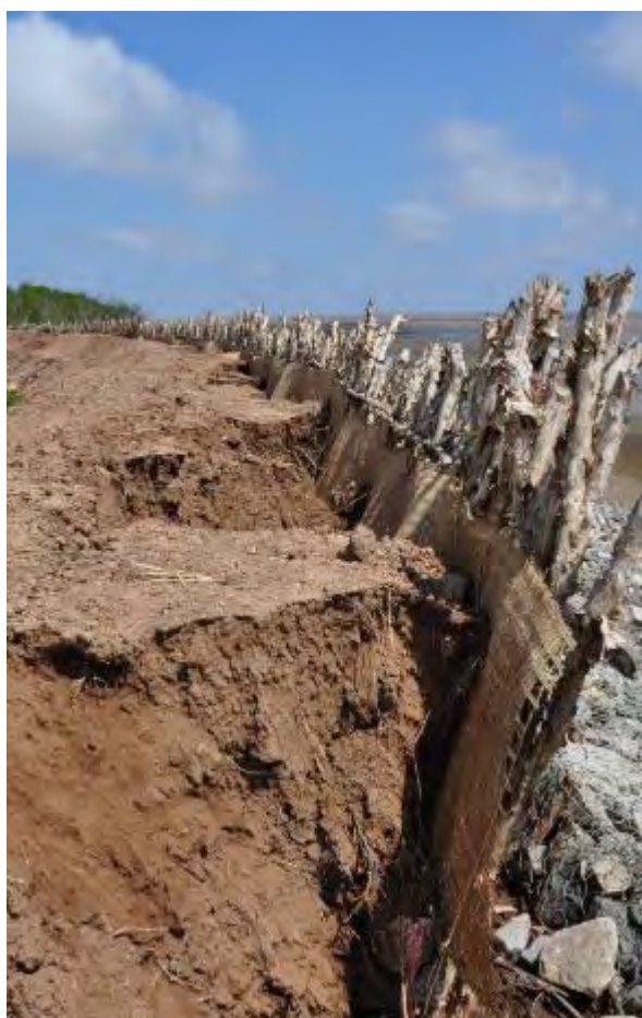
Hình 40. Sự cố đê biển điển hình dọc theo bờ Biển Đông tại ĐBSCL. Khi đê đất có độ dốc lớn và chân đê không được bảo vệ thì cho dù bị sóng đánh ở mức độ vừa phải cũng làm đê bị suy yếu và sụp đổ về phía biển. Khi có những cơn bão trong thời gian dài, mực nước cao và sóng tràn sẽ nhanh chóng phá hủy đê. Nguồn: Frank Thorenz
