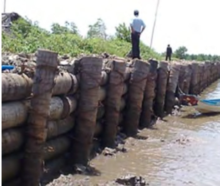
Hình 22. Đê biển tường đứng bằng thân cây dừa. Nguồn: Phan Thanh Tĩnh
