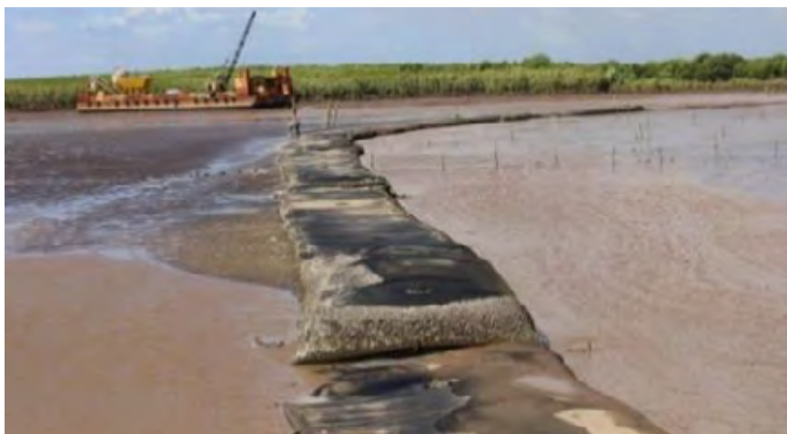
Hình 14. Công trình phá sóng ống vải địa kỹ thuật tách rời. Nguồn: Frank Thorenz
