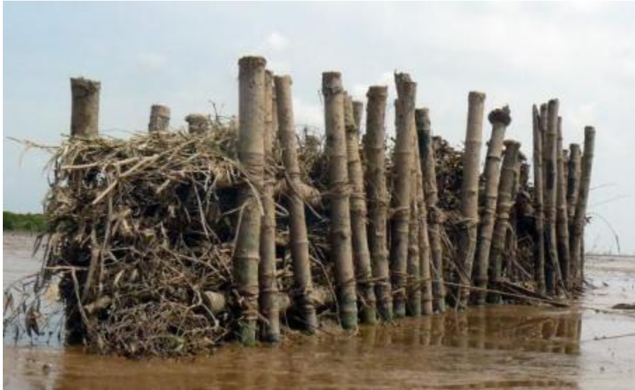
Hình 4: Mặt cắt ngang, mặt hướng ra biển của hàng rào tre
