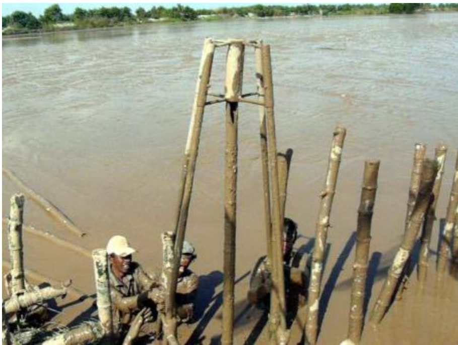
Hình 17: Đóng cọc hàng thứ 2 với búa đầu
