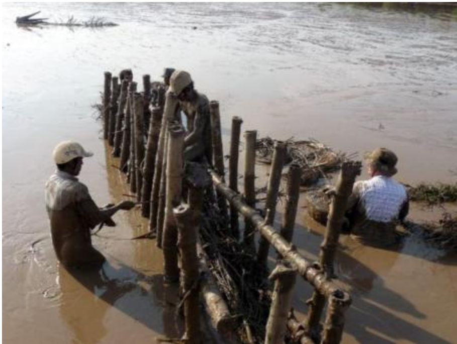
Hình 28: Chuẩn bị buộc mối nối ở cọc ngang phía trên
