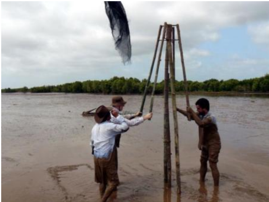
Hình 15: Đóng cọc sử dụng búa đầu với hai người
