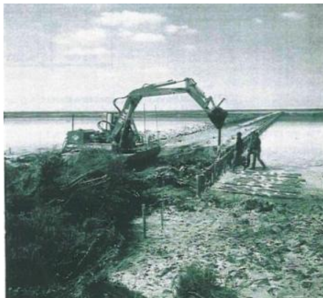
Hình 39: Đóng cọc đứng sử dụng gầu máy đào
