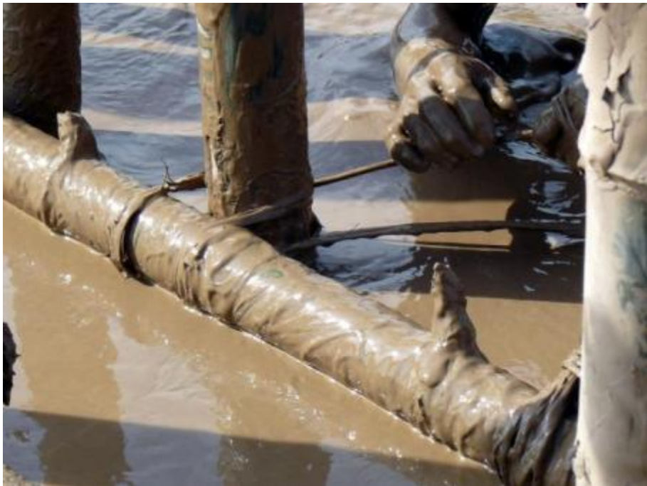
Hình 7: Kết nối thanh ngang vào các cọc đứng
