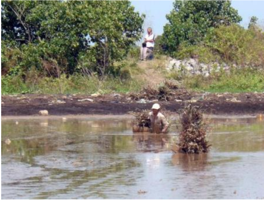
Hình 11: Vận chuyển vật liệu (bó chà) ra địa điểm thi công
