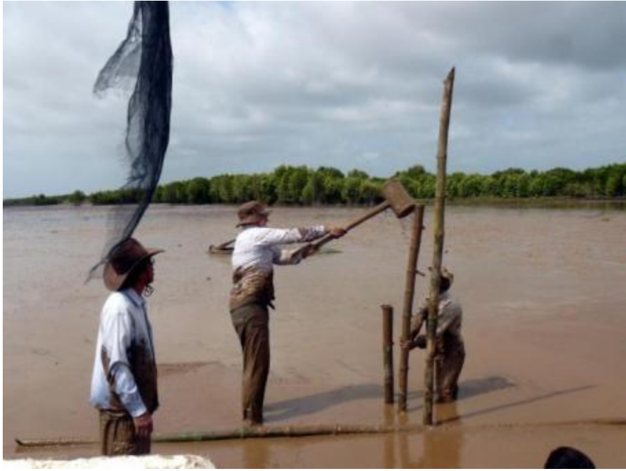
Hình 14: Đóng cọc sử dụng búa tạ
