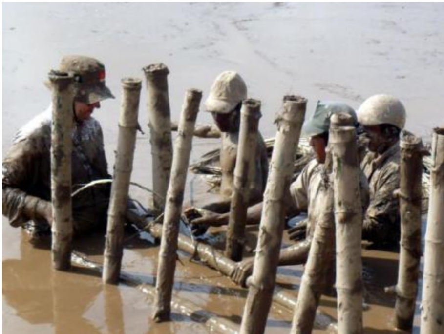
Hình 26: Buộc mối nối của các cọc tre nằm ngang
