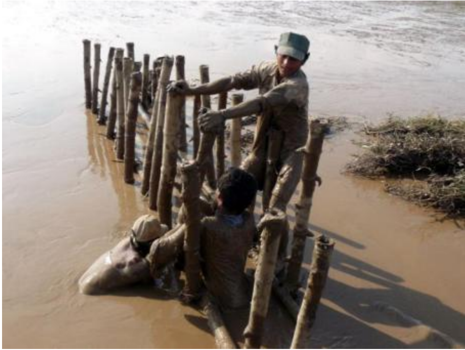
Hình 25: Lắp các cọc tre ngang
