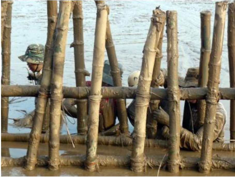
Hình 27: Chuẩn bị buộc mối nối
