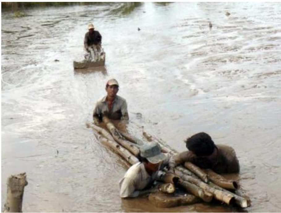
Hình 10: Vận chuyển vật liệu (tre) ra địa điểm thi công
