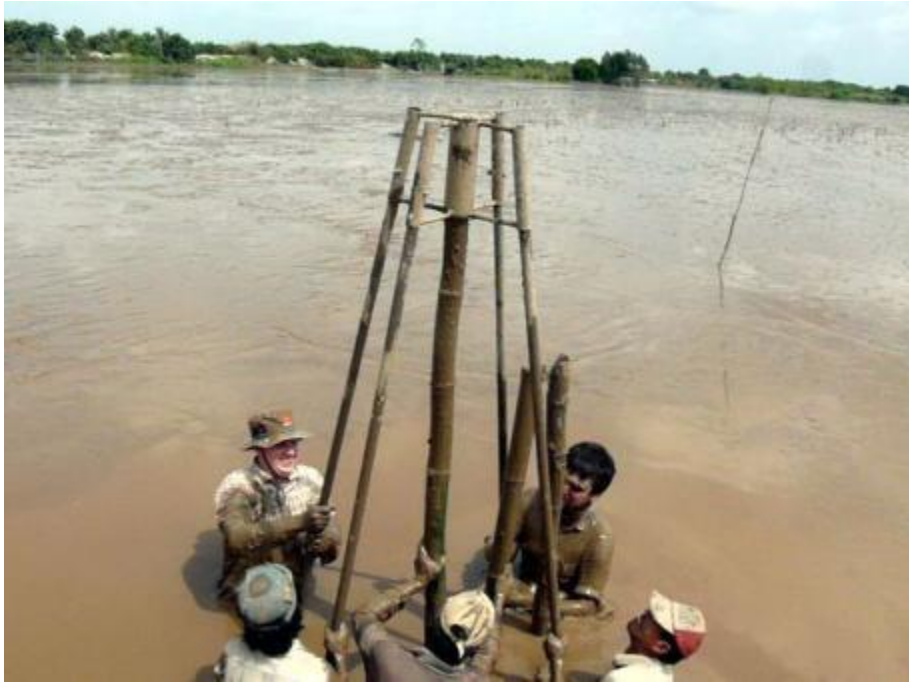
Hình 16: Đóng cọc sử dụng búa đầu với bốn người
