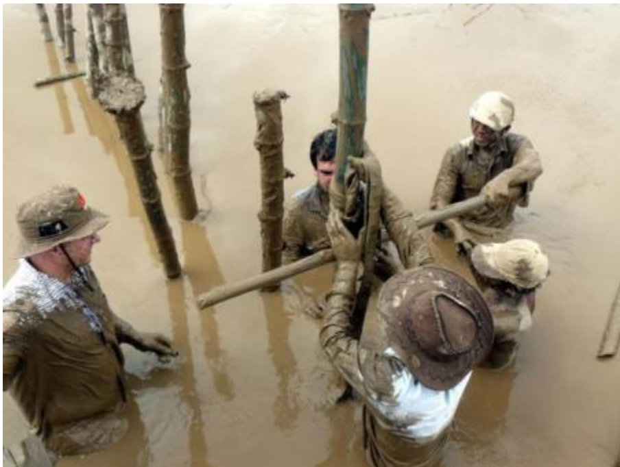
Hình 19: Đóng cọc tre đứng sử dụng kỹ thuật ấn cọc với thanh ngang
