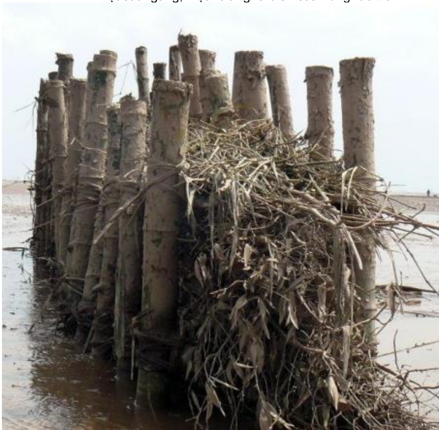
Hình 4: Mặt cắt ngang, mặt hướng ra biển của hàng rào tre
