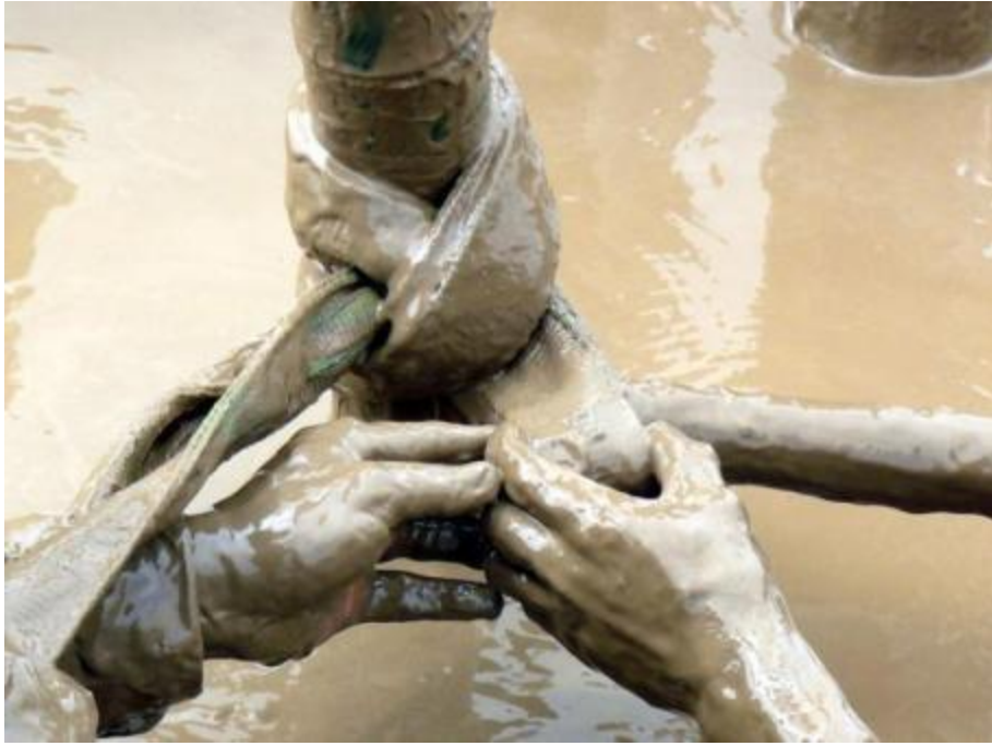
Hình 20: Đưa thanh ngang qua vòng
