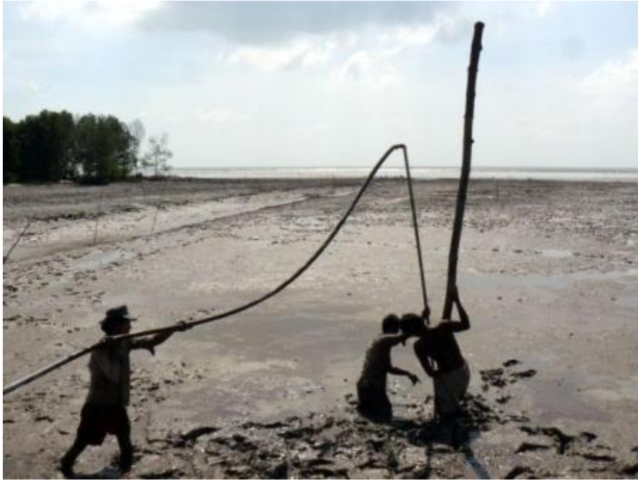
Hình 24: Đóng cọc đứng sử dụng áp lực nước
