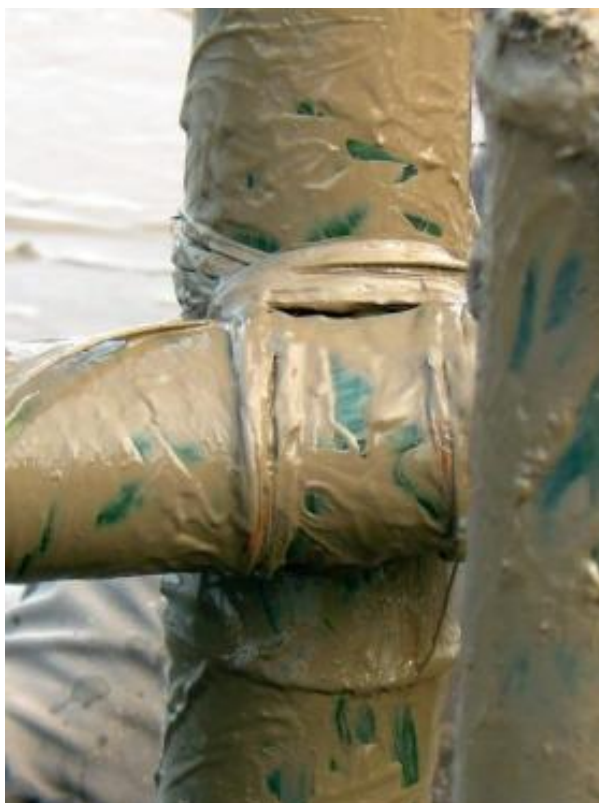
Hình 8: Mối buộc với dây mây
