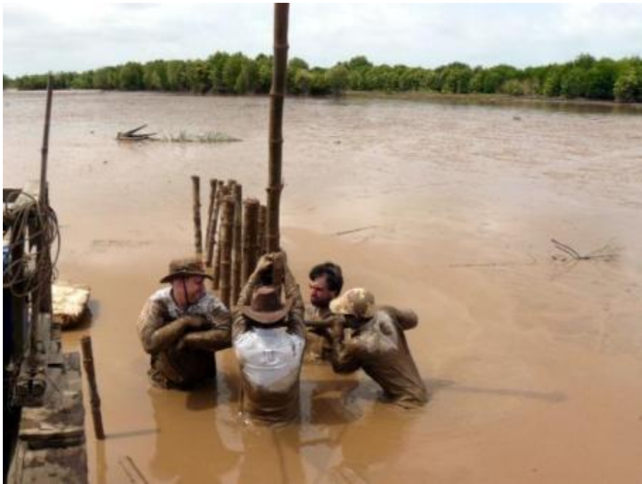
Hình 21: Đóng cọc sử dụng kỹ thuật ấn cọc với thanh ngang
