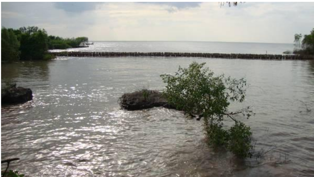
Hình B. Sạt lở đê biển đang diễn ra ở xã Khánh Hội, huyện U Minh, bờ biển tây tỉnh Cà Mau. Trước đây có đai rừng ngập mặn bảo vệ từ bên ngoài, nhưng đai rừng đã bị mất đi trong vài tháng (xem hình C bên dưới). Lý do tại sao rừng ở đây bị mất nhưng chỗ khác rừng vẫn còn nguyên vẫn chưa được làm rõ.
