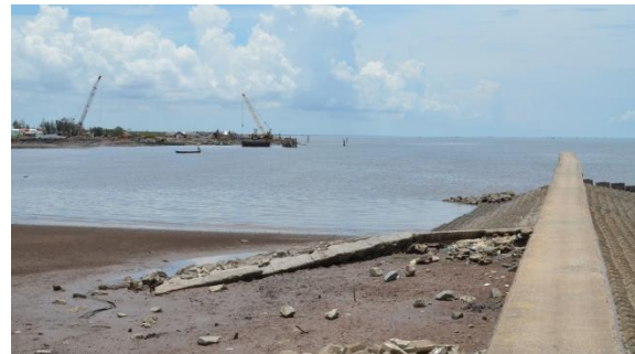
Hình 13: Kè biển ở Gành Hào hiện đang được mở rộng (2014).
