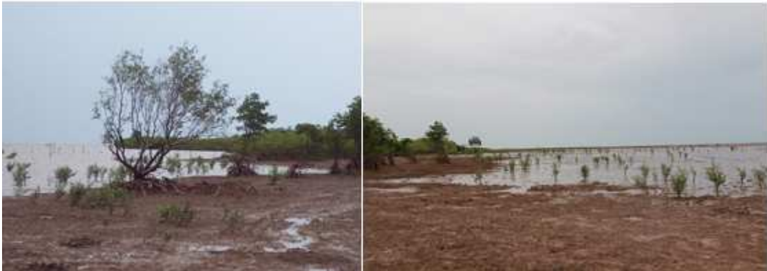
Hình 1: Sạt lở cục bộ tại địa điểm số 4
