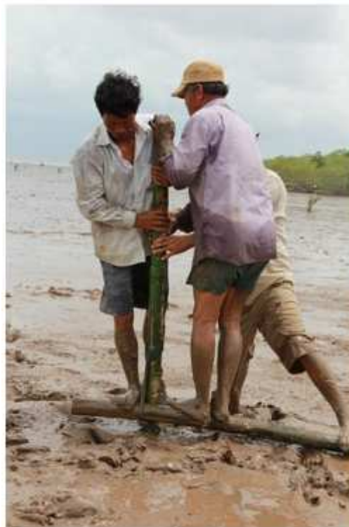
Hình 10: Lắp đặt cọc tre đứng
