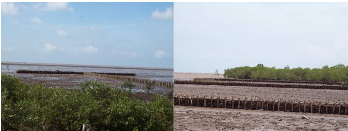
Hình 17: Công trình hàng rào đã hoàn thành
