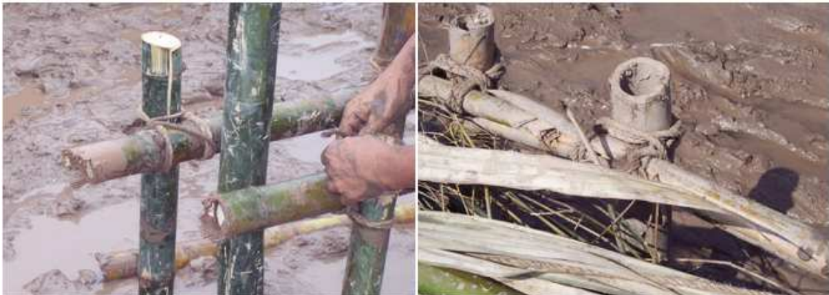
Hình 14: Các mối nối với dây đay
