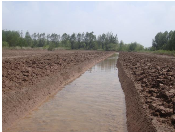
Tháng 6/2011: Bước đầu đào mương.
