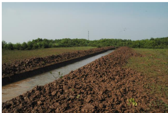
Tháng 6/2011: Bước đầu đào mương.
