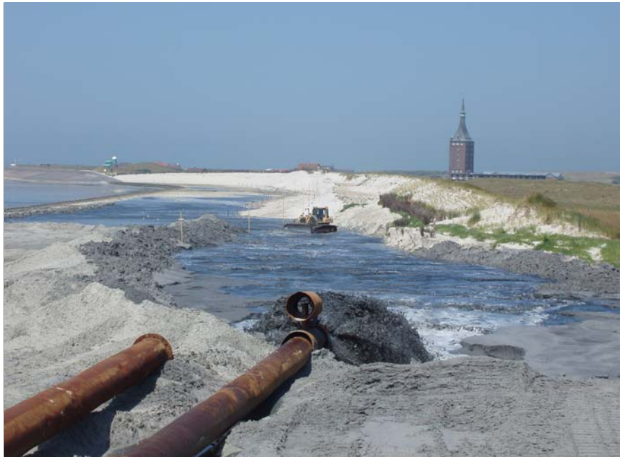
Abb. 5-5: Kombinierte Strandauffüllung und Dünenverstärkung am Harlehörn auf Wangerooge
