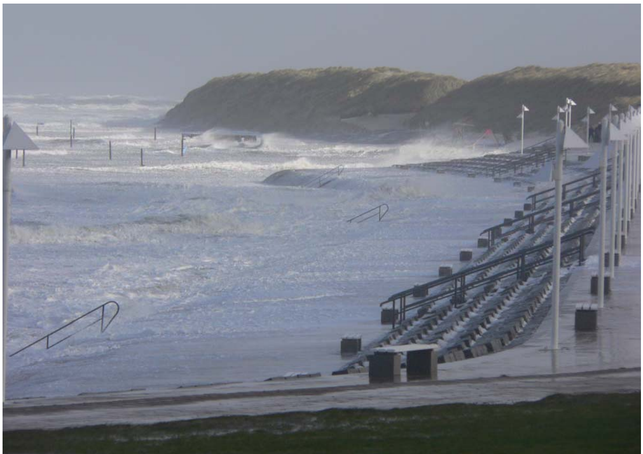
Abb. 9-1: Sturmerprob: Neues Deckwerk auf Norderney
