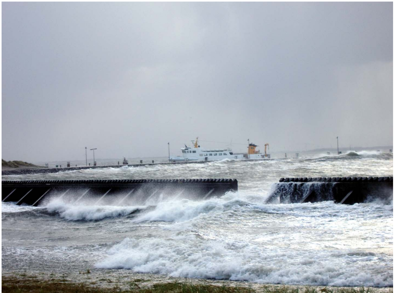
Abb. 6-3: Pfahlschutzwand und Hafen auf Baltrum während einer Sturmflut
