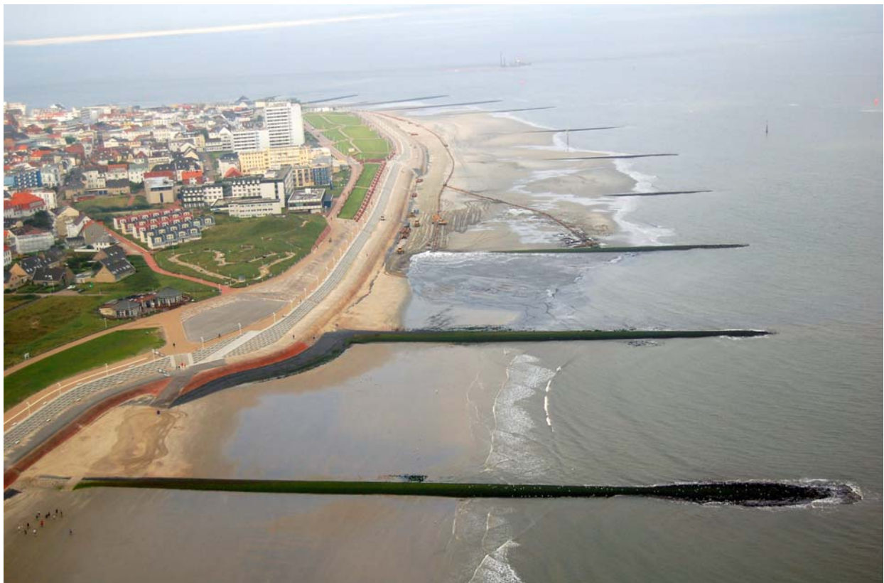
Abb. 8-1: Strandaufspülung zum Schutz des Westkopfes Norderney
