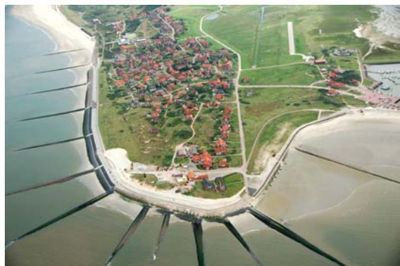
Abb. 3-2: Massiv durch Deckwerke und Bühnen befestigter Westkopf von Baltrum
