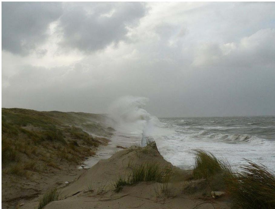
Abb. 8-7: Schumacherwand auf Spiekeroog während der Sturmflut vom 9.11.2007
