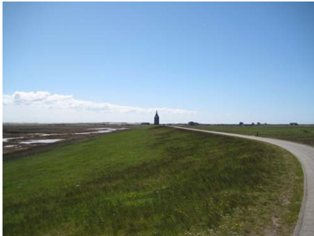
Abb. 8-8: Westgrodendeich auf Wangerooge
