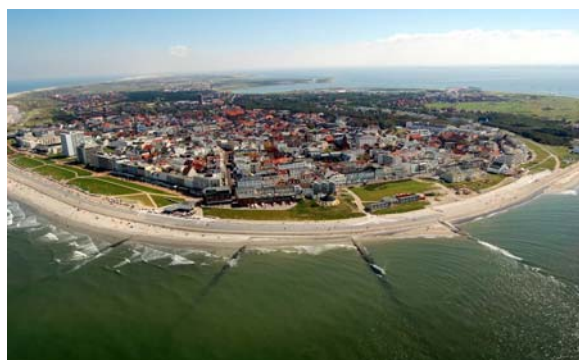
Abb. 5-3: Durch Deckwerke und Bühnen gesicherter Westkopf von Norderney
