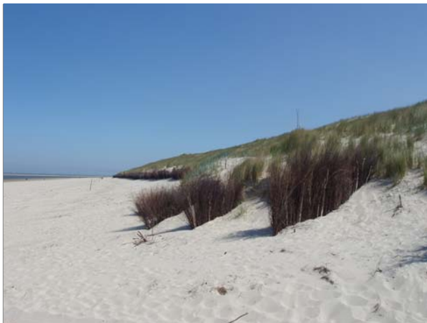
Abb. 5-7: Sandfangmaßnahmen am Dünenfuß
