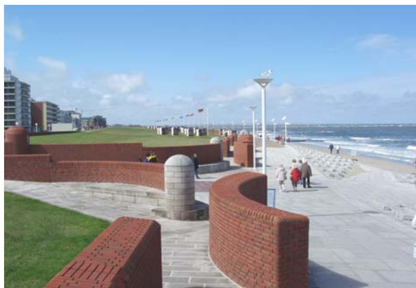
Abb. 5-4: Schwallmauern zur Verringerung des Wellenaufbaus am Nordstrand von Norderney im Sommer und während der Sturmflut vom 9. November 2007
