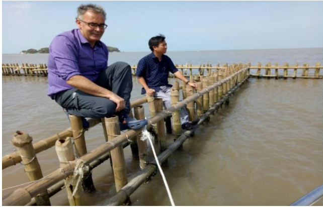
Hình 3a và 3b: Kè bằng tre và các khối rỗng ở Cà Mau (Nguồn: tỉnh Cà Mau)
