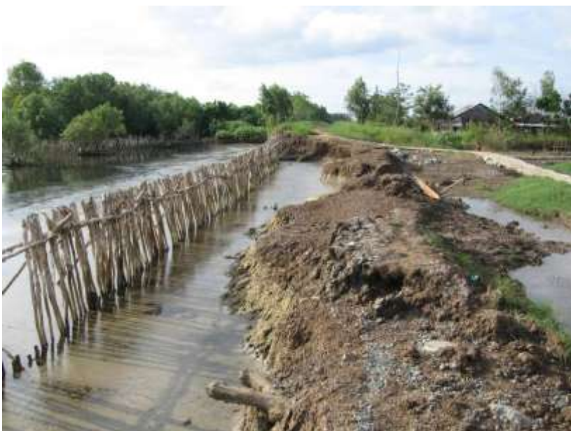
Hình 18: vật liệu làm đập không đồng chất
