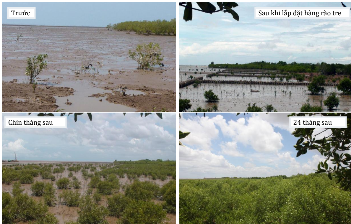
Hình 6: Phục hồi vịnh đất bị xói lở bằng hàng rào tre chắn sóng (từ trên bên trái xuống dưới cùng bên phải): trước, sau khi lắp đặt hàng rào, lượt tái sinh tự nhiên chín tháng và 24 tháng sau. (Ảnh: P.V. Hoàng & L.T. Phong ©GIZ)
