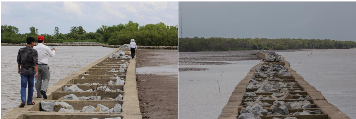
Hình 2a và 2b: Các kè mỏ hàn cột bê tông của phía bắc Khánh Hội đoạn vuông góc và đoạn song song với bờ biển (Hình: Thorenz)
