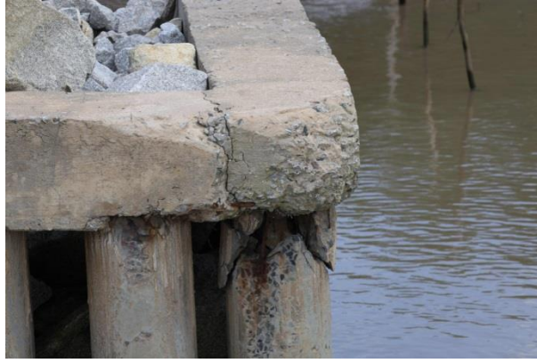
Hình 4a, 4b và 4c: Các lỗi thi công và hư hỏng ở phần cột và dầm (Hình: Thorenz)
