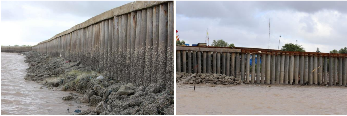
Hình 9a và 9b: Bảo vệ đường bờ ở sông Gành Hào, tỉnh Cà Mau (Hình: Thorenz)
