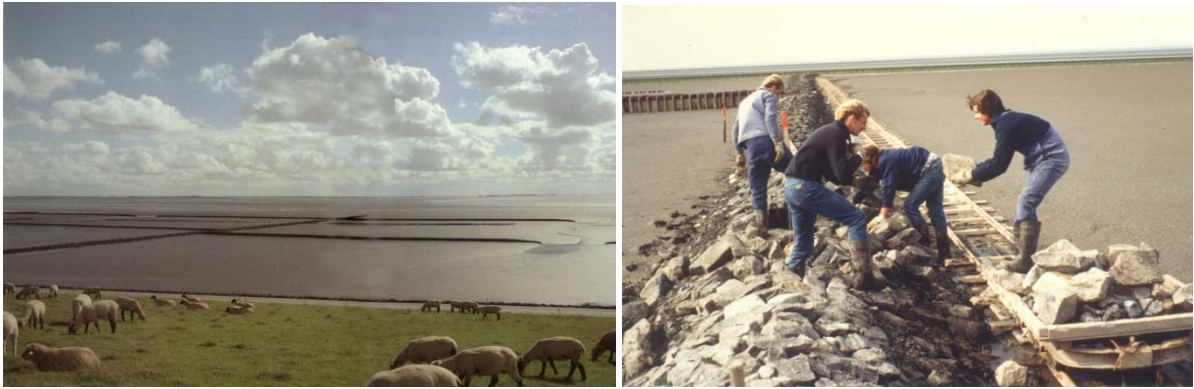
Hình 7a và 7b: Bãi kè và duy tu kè tại Lower Saxony, Đức (Hình: NLWKN).
