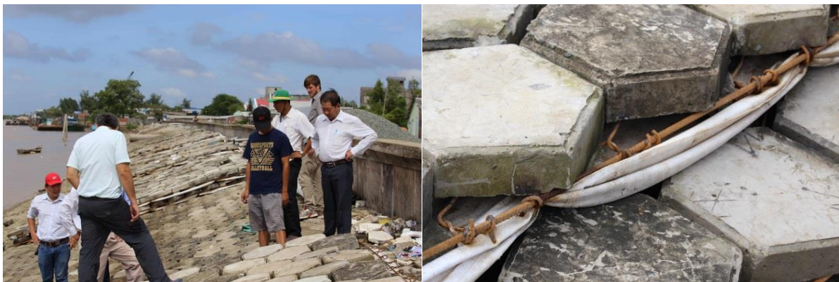
Hình 10a và 10b: Kè lát mái bằng các tầng bê tông tại sông Gành Hào phía bờ tỉnh Bạc Liêu (Hình: Thorenz)
