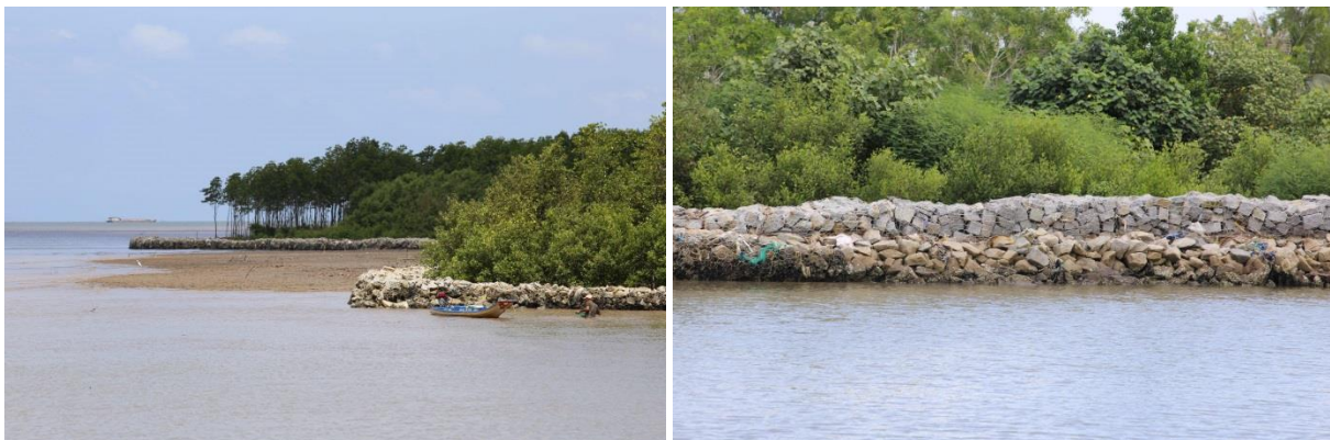
Hình 6a và 6b: Đai rừng ngập mặn được bảo vệ bởi các rọ đá ở phía bờ bắc của cửa kênh (Hình: Photos Thorenz)
