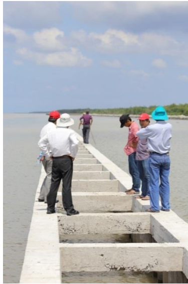
Hình 3: Kè mở hàn tại phía bắc của cửa kênh sử dụng đầm nhỏ hơn đang được thi công (Hình: Thorenz)
