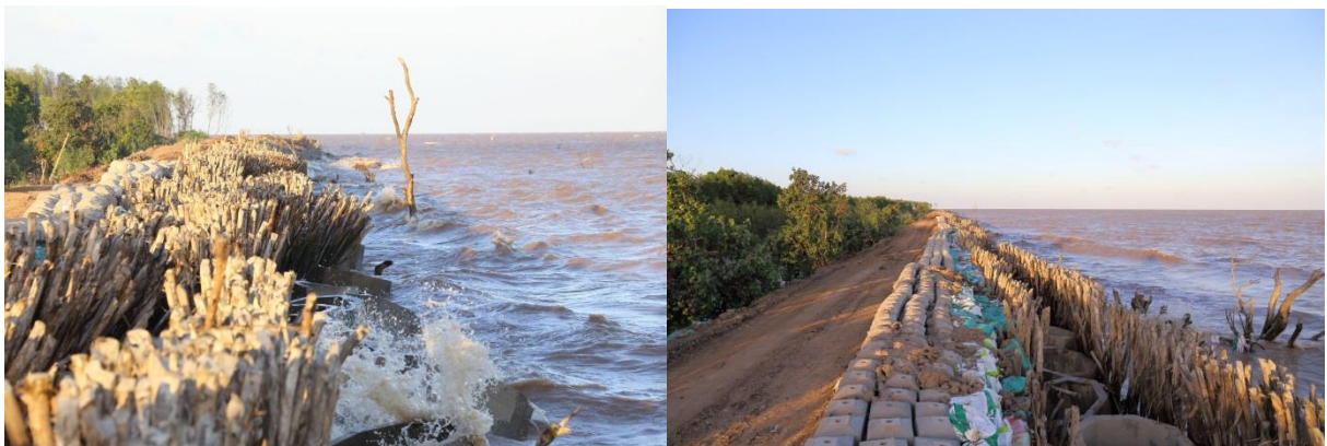
Hình 18a và 18b: Nâng cấp đê bằng nhiều biện pháp tại tỉnh Sóc Trăng gần sông Mỹ Thanh (Hình: Thorenz)
