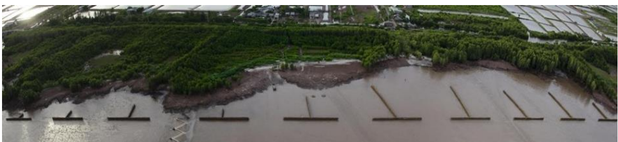
Hình 3: Khôi phục các bãi biển bị xói lở bằng hàng rào tre ở tỉnh Bạc Liêu (ĐBSCL, Việt Nam). Các cấu trúc dọc bờ khép kín các khoảng trống bị xói lở trong rừng ngập mặn bằng cách kết nối các mũi đất còn sót lại. Hình ảnh do Công Lý và G.E. Wind 2013 cung cấp.
