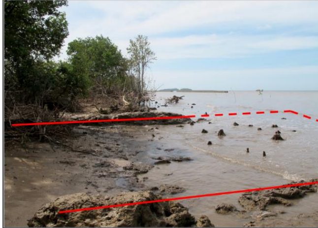
Hình 3. Ao nuôi tôm trước đây được phục hồi với các kè nhỏ bị tiếp xúc với biển do mất rừng phòng hộ ở phía trước rừng sản xuất.
