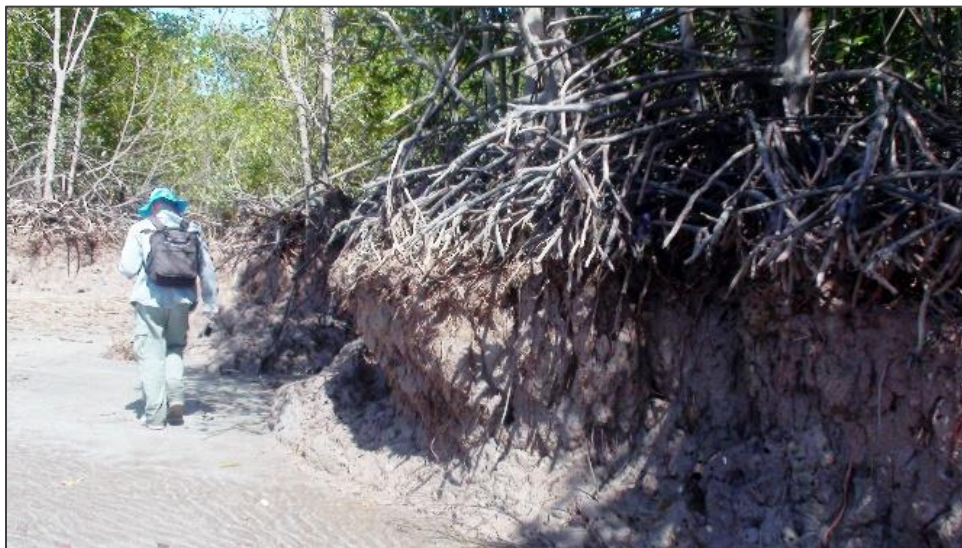
Hình 1. Vách đất xói lở ở bờ biển Tây – Cà Mau. Lớp đất có rừng ngập mặn bị xói chân và sụp xuống. Thực tế cho thấy tình trạng không còn gì sót lại phía trước của vách đất xói lở là một dấu hiệu của một quá trình xói lở nhanh và mạnh.
